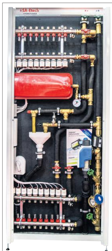
So sieht die Innenansicht einer Haustechnik-Kompaktanlage aus.
