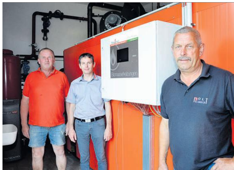
Im Kesselhaus wurden Ofen, Druckhalteanlage und sämtliche Verrohrungen erneuert.
