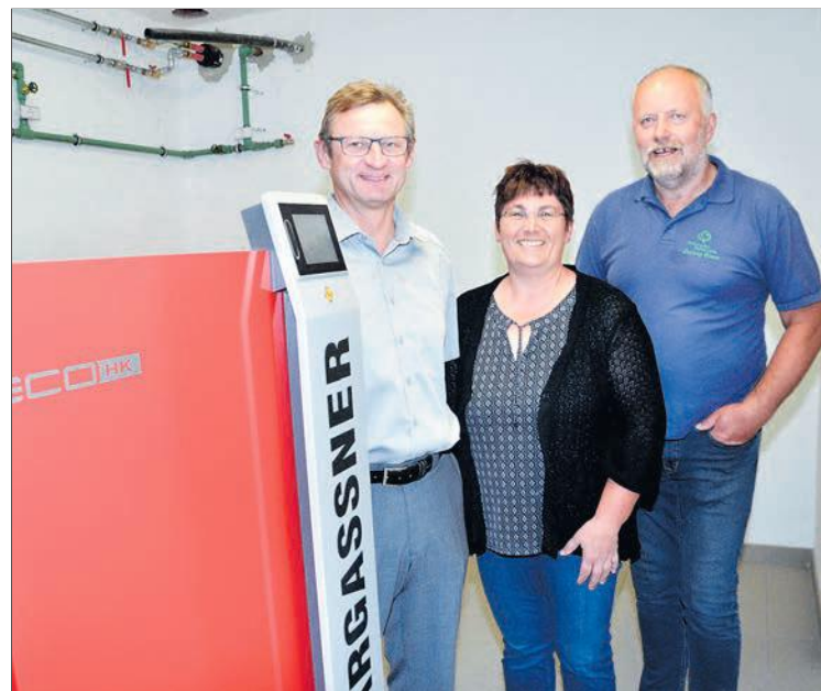
Appel-Techniker Otto Mauritz mit Anita und Ludwig Bauer vor ihrer neuen Hackschnitzel-Heizungsanlage in Merkengersch.
