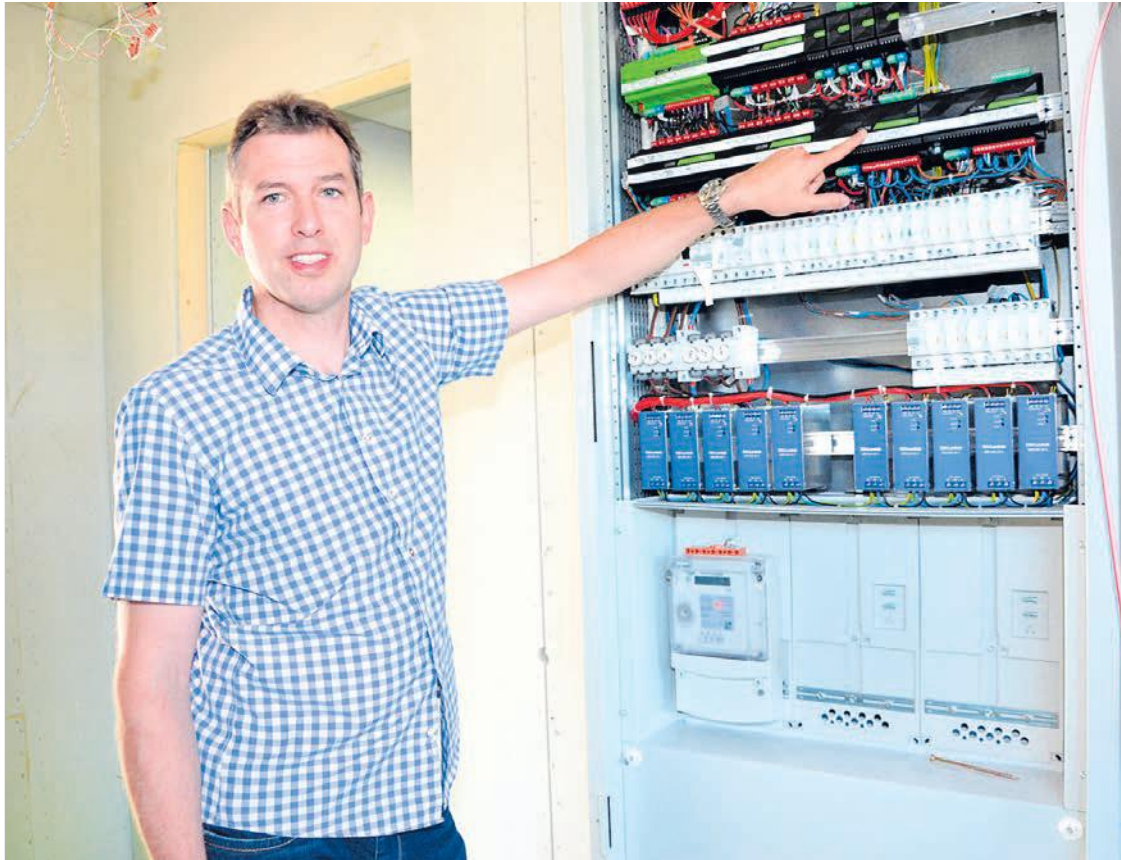
Wolfgang Kahl vor seinem Verteilerschrank, durch das Loxone-System kann er viele Dinge in seinem Haus steuern.
