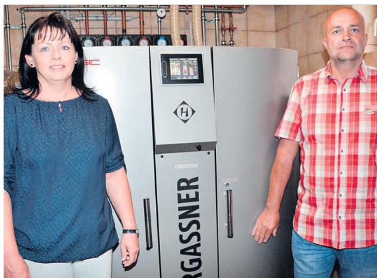
Helmut und Monika Schandl vor ihrem neuen Pellets-Heizkessel.
