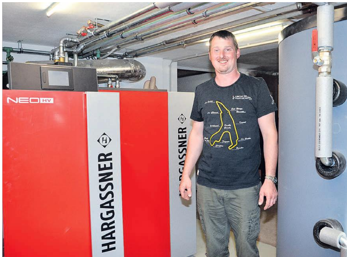
Herbert Flicker mit seiner neuen Heizanlage und den Pufferspeichern im Heizraum seines Hauses in Pfaffenschlag.
