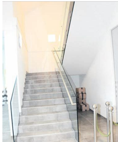
Der Stiegenaufgang zu den neuen Hotelzimmern wurde ebenfalls von der Firma Appel gefliest.
